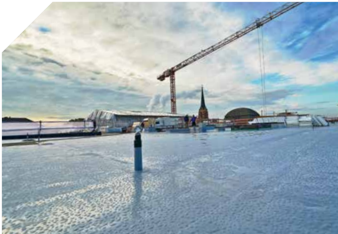
▲ Ohne Flamme: Die EPDM-Bahnen wurden im Kaltklebverfahren verlegt
