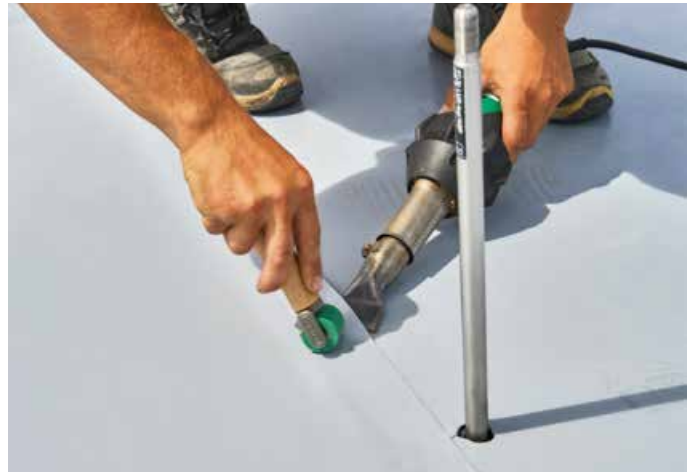
▲ Im Detail: Materialhomogene Nahtföugung mit dem Handschweißgerät
